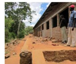
まず、リテンド壁を作り基礎周りの土を埋め戻しその後、教室の構造補修→
