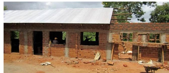
↑ 壁を切り、鉄筋コンクリートの柱を入れたのが白い部分。横方向につなぐ鉄筋のはり
